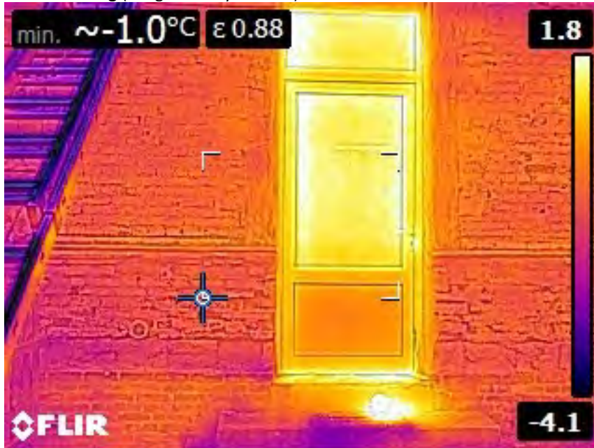
Mur extérieur avant application
