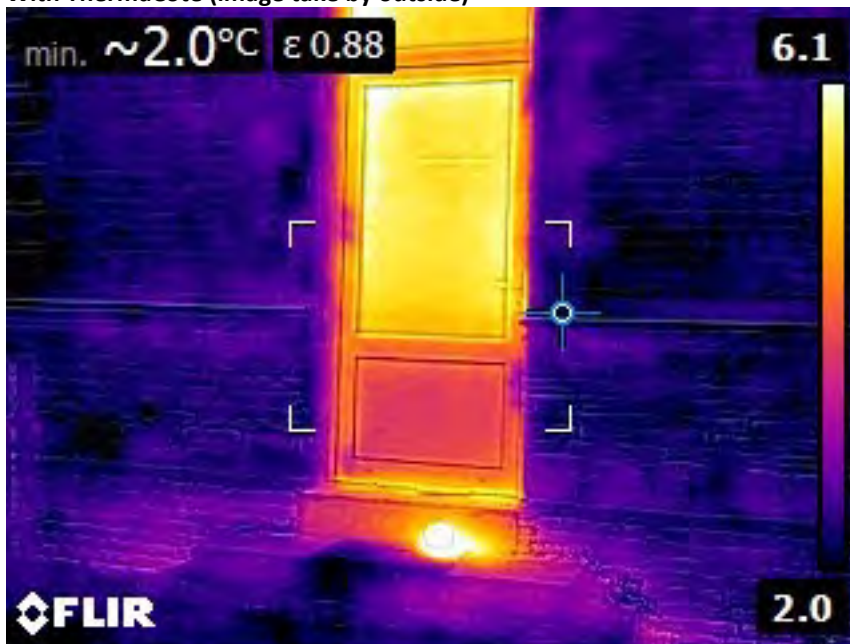
Mur extérieur avec ThermaCote
